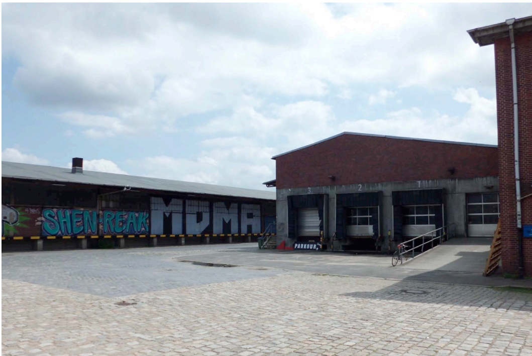
Zugangsbereich mit Rampe und Rolltoren
