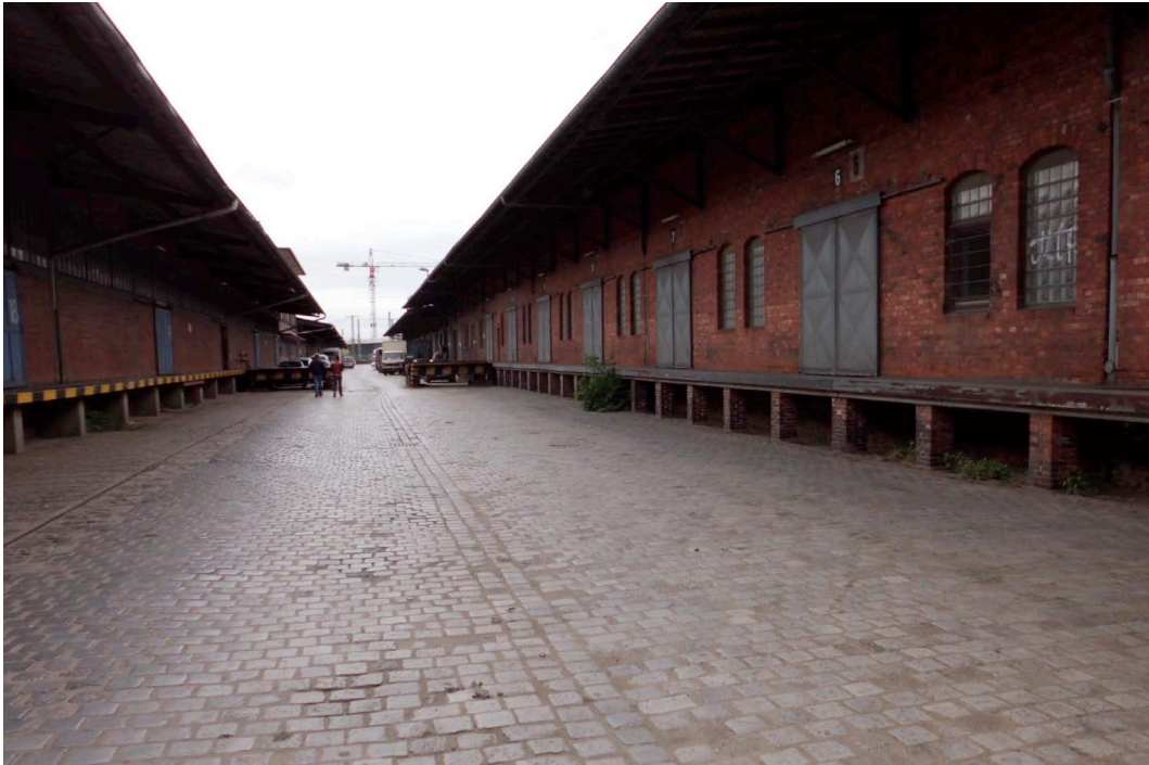
Straße zwischen Güterhallen 2 und 3 sowie Seitliche Laderampe
